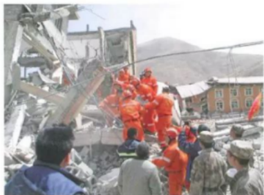
2010年4月国家地震灾害紧急救援队在青海玉树地震后开展搜索营救、医疗救助、后勤保障等救援工作。图为救援队正在废墟中进行搜救。
